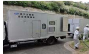
電源車接続訓練
